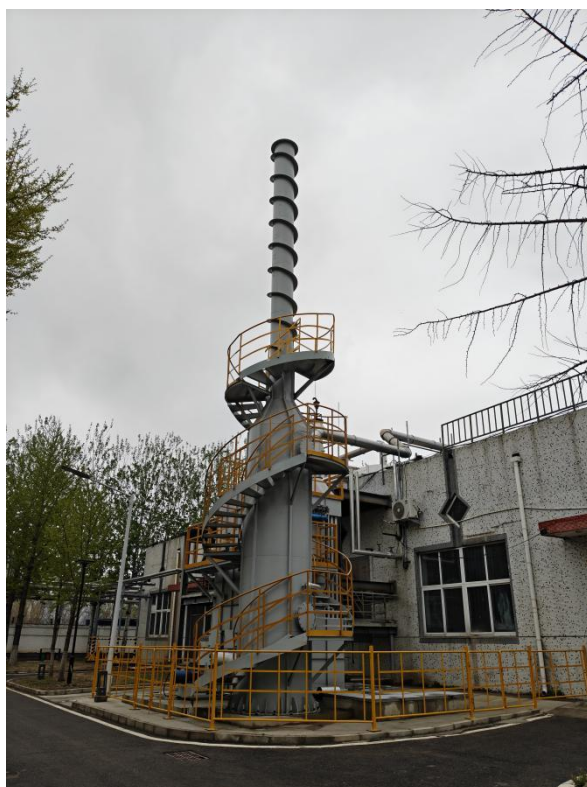
图 9-1 废气处理设施及排气筒
